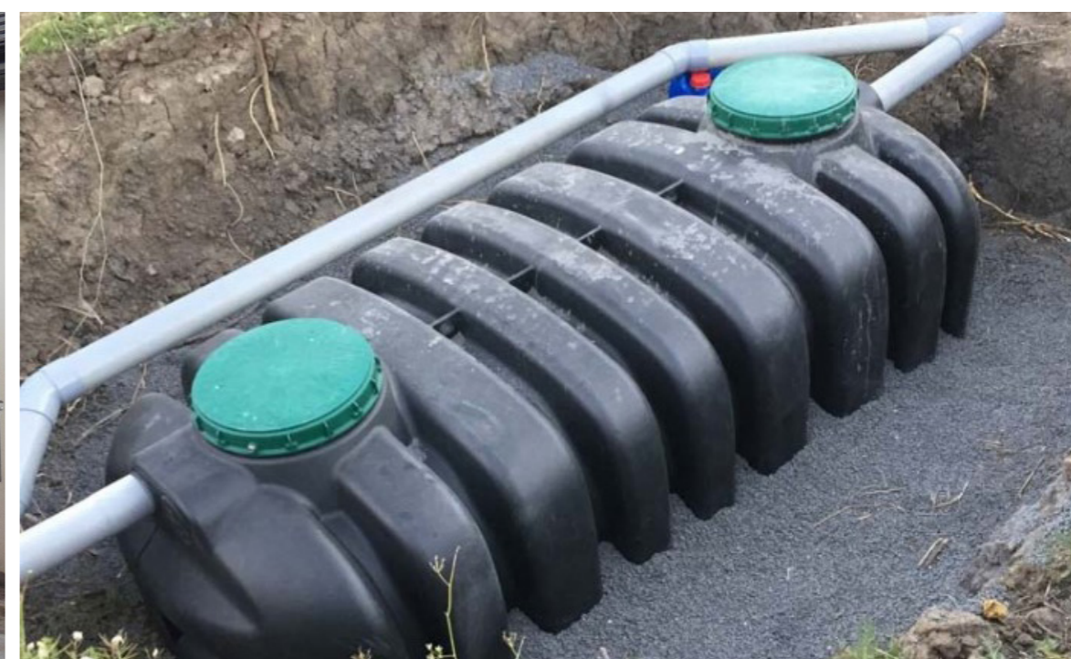
Eau usée : Modèle d'installation de fosse septique enterrée, qui sera vidée et deterrée après utilisation
